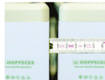
Abb. 5-14: 10 mm Abstand zwischen den Batteriezellen
